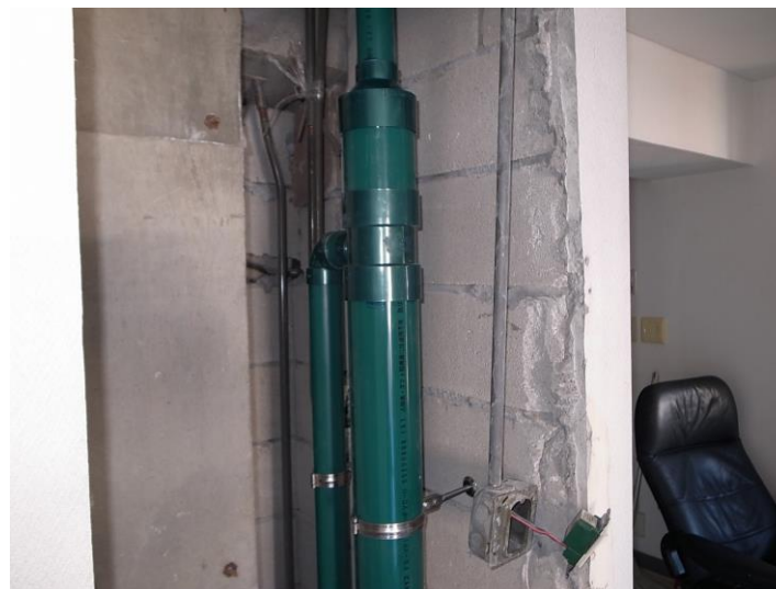
キッチンP S壁開口 排水管更新
