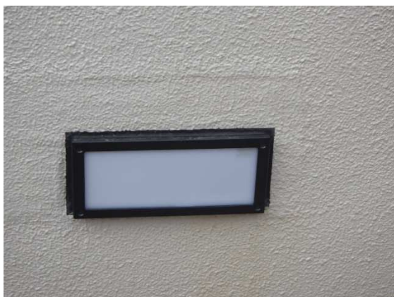
作業前 既存フットライト
