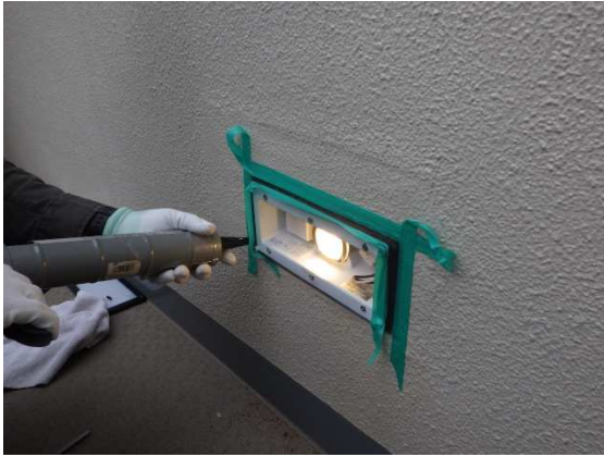
点灯確認・シリコンシール施工中
